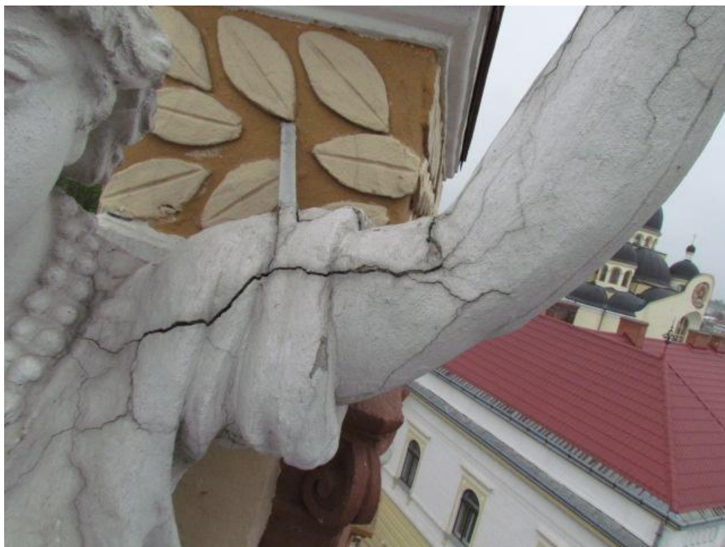
Рис. 3.1.41. Фрагмент скульптурної композиції з пошкодженням. Національний Музей Гуцульщини та Покуття, м. Коломия, Івано-Франківська область. Стан до проведення реставраційних робіт
