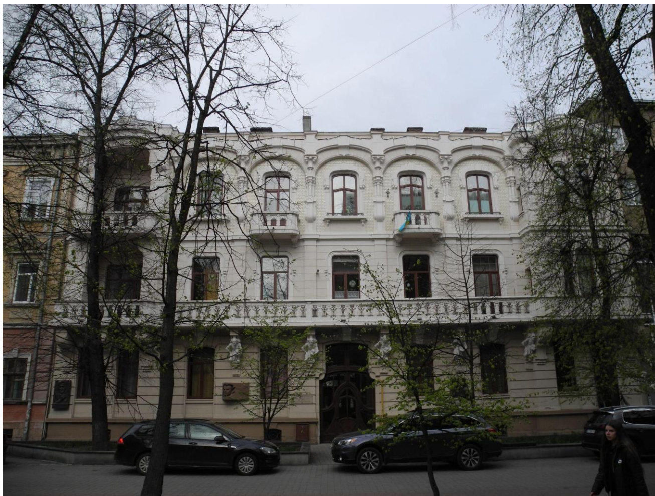
Рис. 3.1.32. Декоративна система головного фасаду № 44, вул. Шевченка, м. Івано-Франківськ. Стан після завершення реставраційних робіт (без відновлення мурованого аттику)
