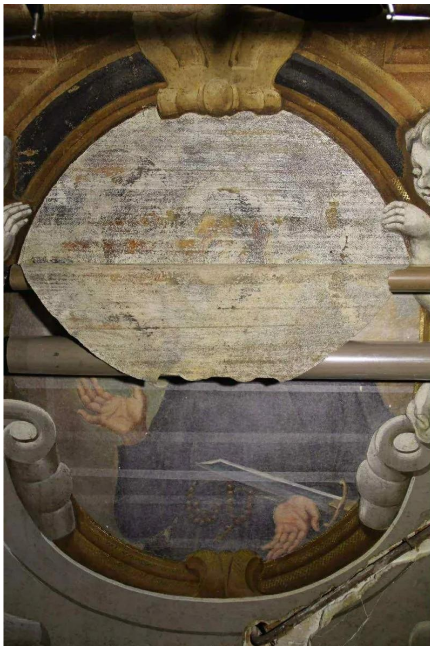
Рис. 3.1.9. Процес розшарування настінного живопису під час реставраційних робіт 2022 року. Святилище Гарнізонного храму святих апостолів Петра і Павла (колишній костел Єзуїтів), м. Львів
