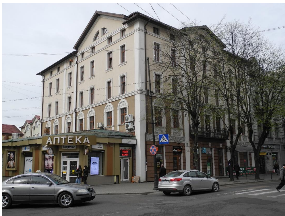
Рис. 3.2.20. Загальний вигляд будинку № 18, вул. Січових Стрільців, м. Івано-Франківськ. Сучасний стан після реконструкції
