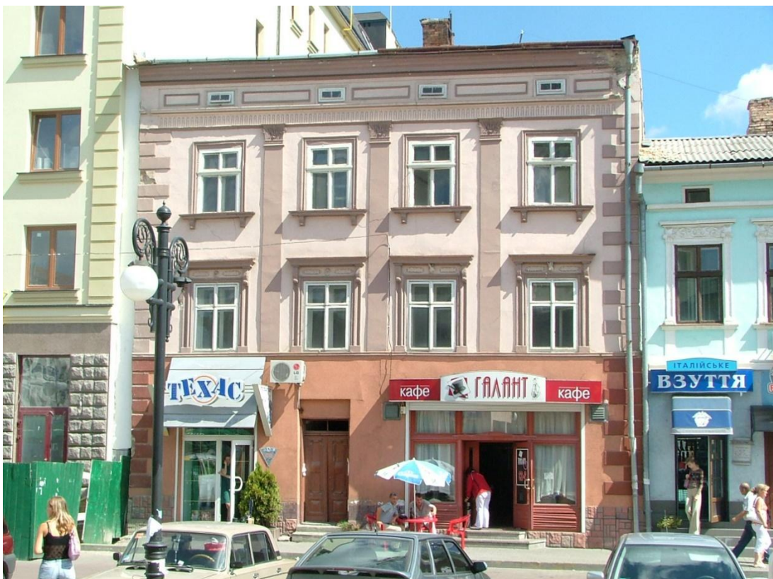
Рис. 3.2.8. Загальний вигляд будинку № 5, пл. Ринок, м. Івано-Франківськ. Стан до реконструкції
