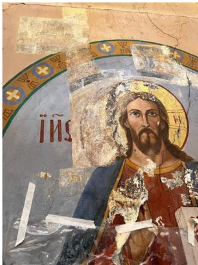
Рис. 3.1.12. Процес видалення пізніших олійних пофарбувань. Розпис церкви Пресвятої Трійці, м. Бережани, Тернопільська область. Стан підчас реставраційних робіт 2022 року
