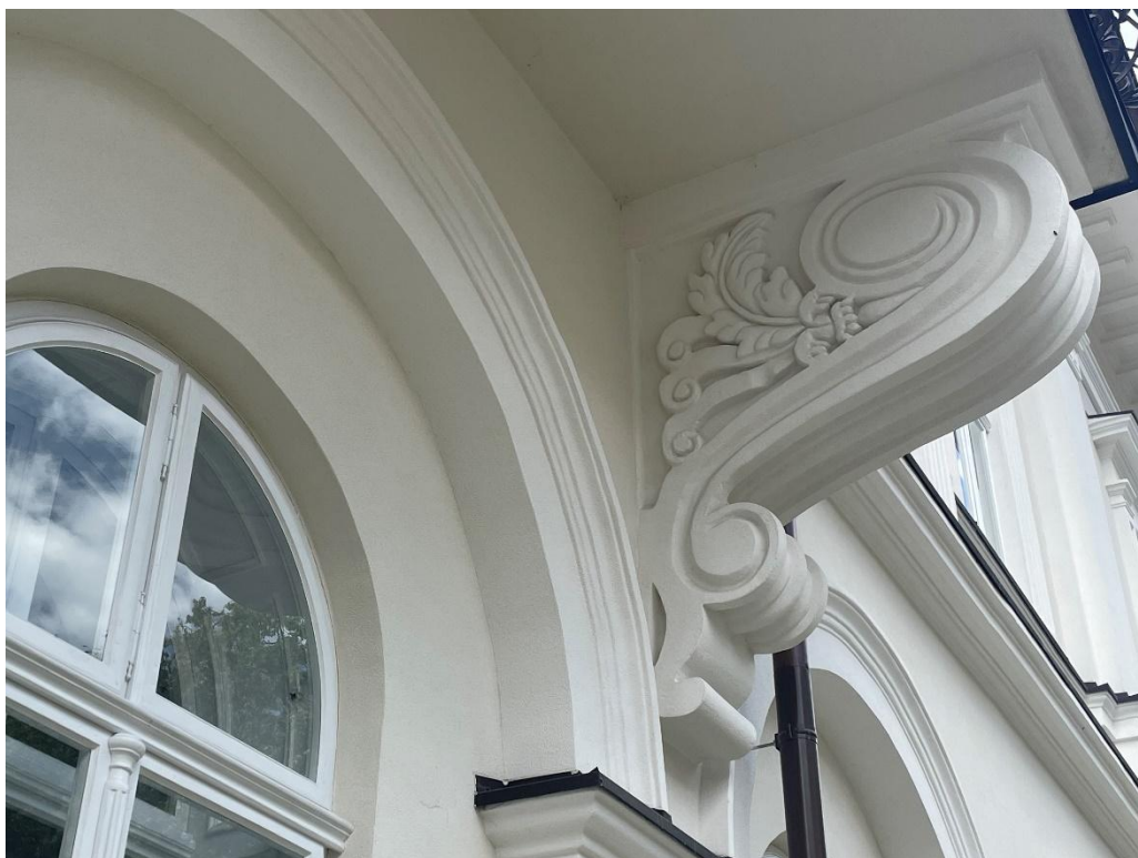
Рис. 3.1.49. Вигляд відновленої декоративності будівлі № 16, вул. Шевченка, м. Івано-Франківськ. Стан після завершення реставраційних робіт
