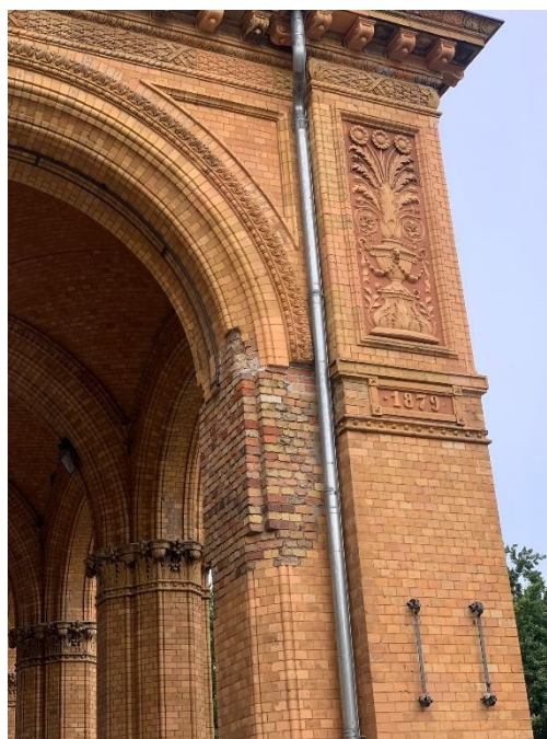
Рис. 3.1.54. Фрагмент стіни колишньої станції Ангальтського вокзалу, м. Берлін, Німеччина. Збереження декоративності фасаду. Стан після проведення консерваційних заходів
