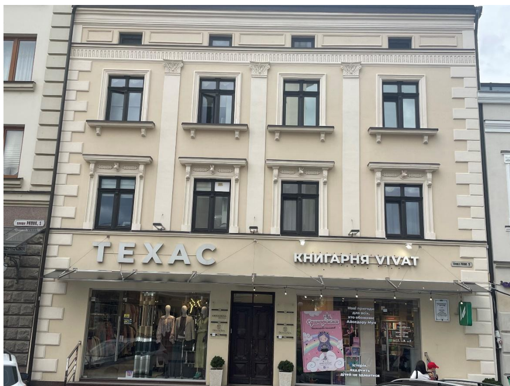
Рис. 3.2.10. Загальний вигляд будинку № 5, пл. Ринок, м. Івано-Франківськ. Стан після реконструкції
