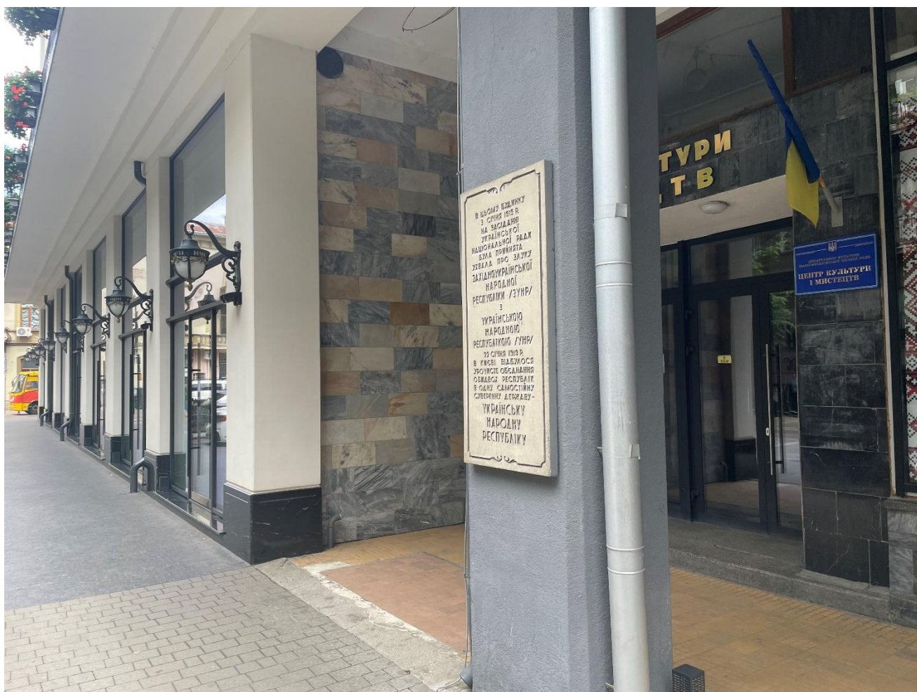
Рис. 3.2.31 Фрагмент простору відкритої та закритої частини колониади будівлі готелю «Дністер», м. Івано-Франківськ. Сучасний стан після реконструкції
