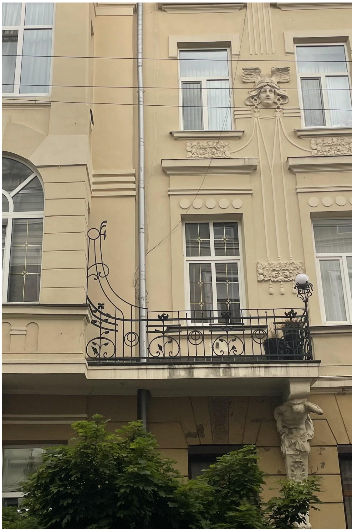
Рис. 3.1.35. Фрагмент фасаду будинку № 5-7-9, вул. Курбаса, м. Івано-Франківськ. Стан після завершення реставраційних робіт
