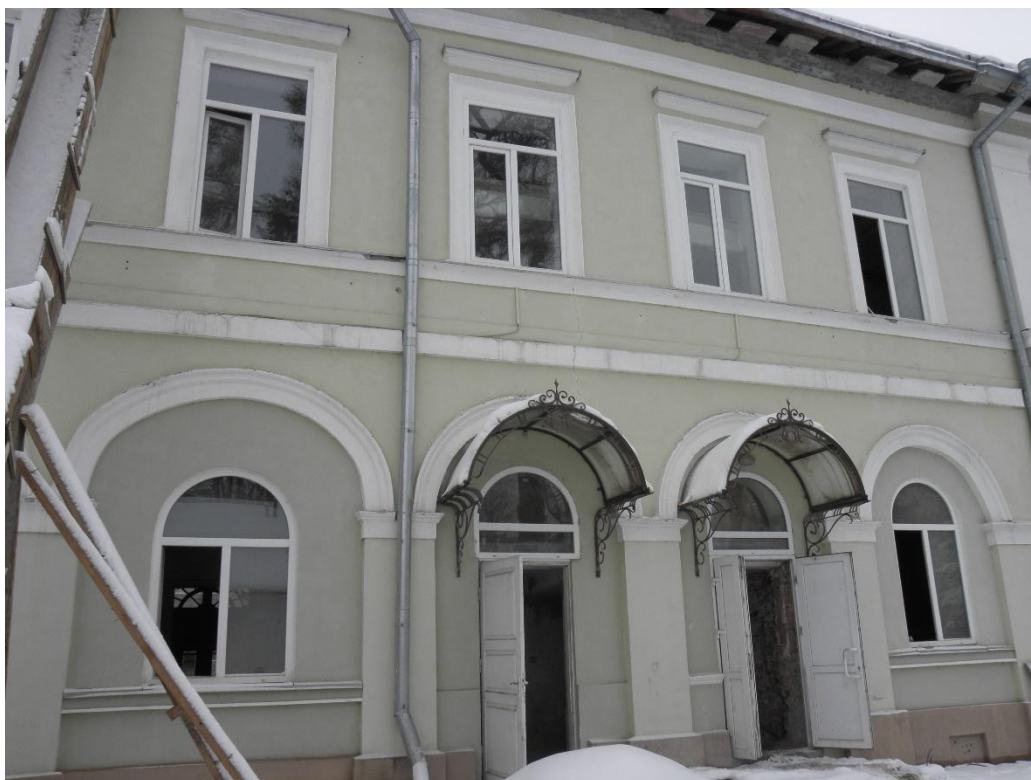
Рис. 3.1.47. Фрагмент західного фасаду будівлі № 16, вул. Шевченка, м. Івано-Франківськ. Стан до проведення реставраційних робіт
