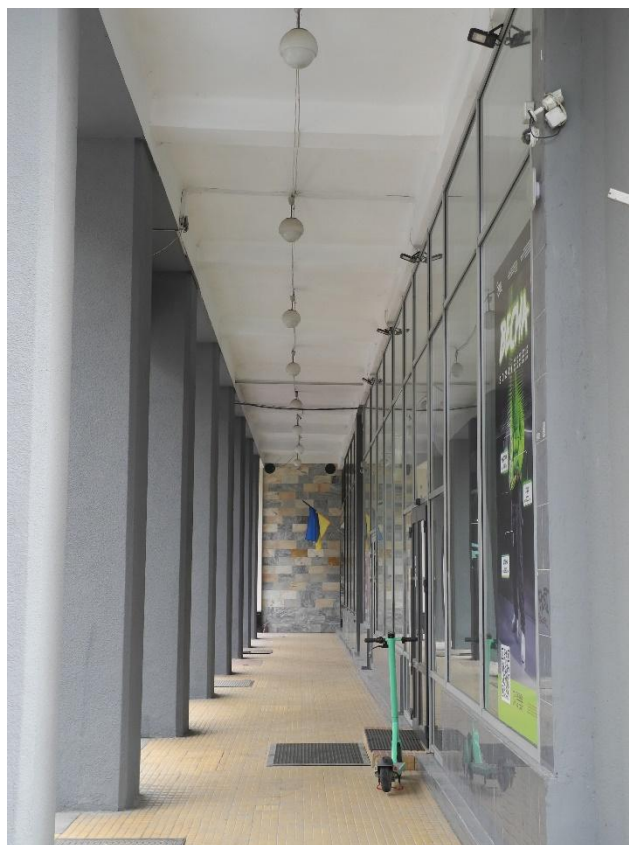
Рис. 3.2.29 Колонада зі сторони вул. Шевченка після реконструкції і приєднання до внутрішнього об'єму будівлі готелю «Дністер», м. Івано-Франківськ. Сучасний стан після реконструкції
