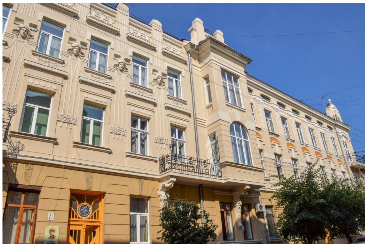
Рис. 3.1.37. Фрагмент фасаду будинку № 5-7-9, вул. Курбаса, м. Івано-Франківськ. Сецесійні декоративні елементи. Стан після завершення реставраційних робіт
