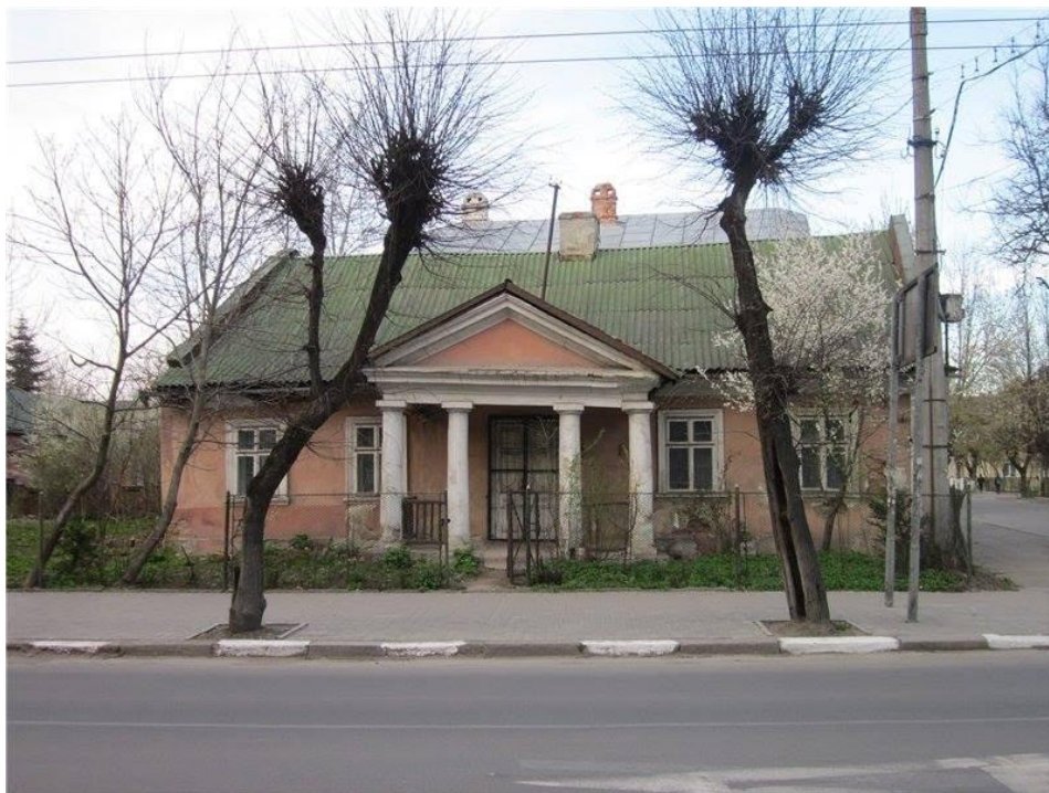
Рис. 3.2.6. Загальний вигляд садиби Гриневичів по вул. Василянок, 52, м. Івано-Франківськ. Стан до знесення
