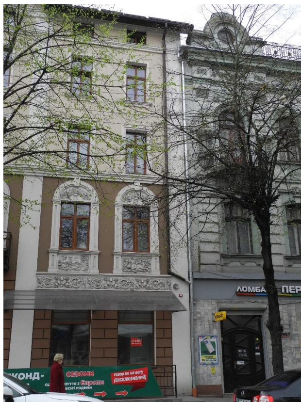
Рис. 3.2.22. Фрагмент декоративності фасаду будинку № 18, вул. Січових Стрільців, м. Івано-Франківськ. Сучасний стан після реконструкції
