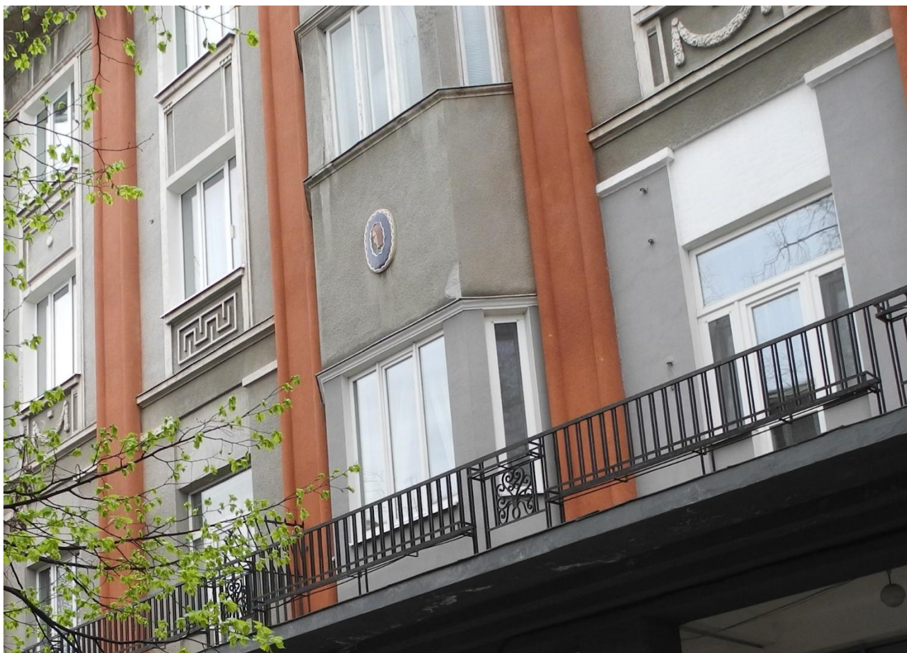
Рис. 3.2.27 Декоративні елементи бокового фасаду готелю «Дністер», м. Івано-Франківськ. Стан до реконструкції
