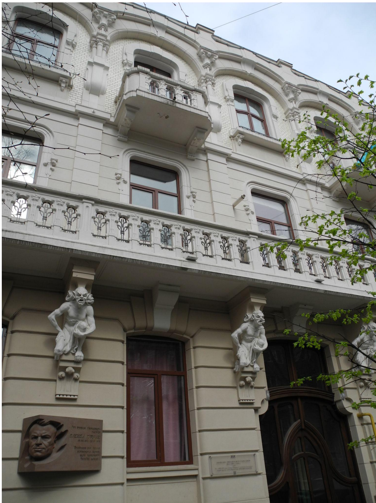
Рис. 3.1.31. Фрагмент фасаду будинку № 44, вул. Шевченка, м. Івано-Франківськ. Стан після завершення реставраційних робіт
