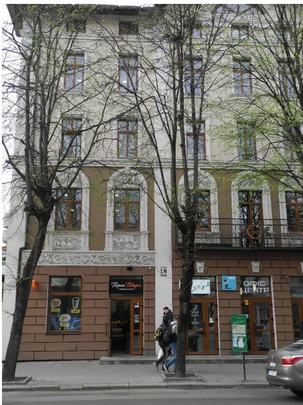
Рис. 3.2.21. Фрагмент декоративності фасаду будинку № 18, вул. Січових Стрільців, м. Івано-Франківськ. Сучасний стан після реконструкції
