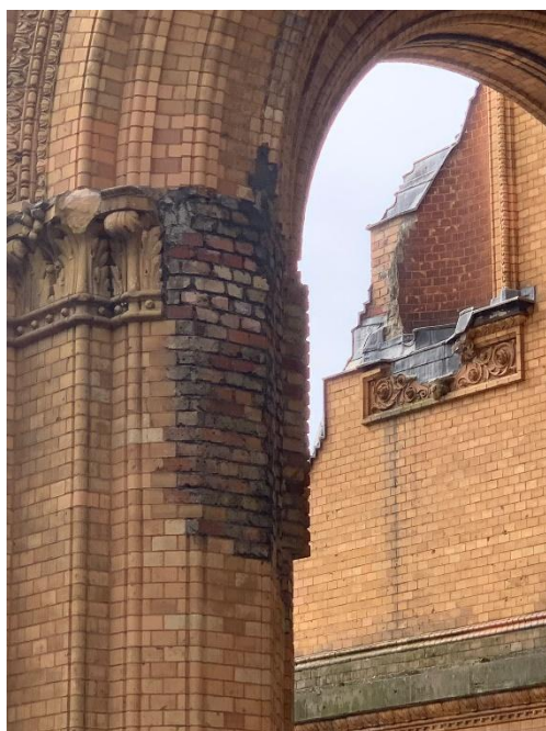
Рис. 3.1.54. Фрагмент стіни колишньої станції Ангальтського вокзалу, м. Берлін, Німеччина. Збереження декоративності фасаду. Стан після проведення консерваційних заходів
